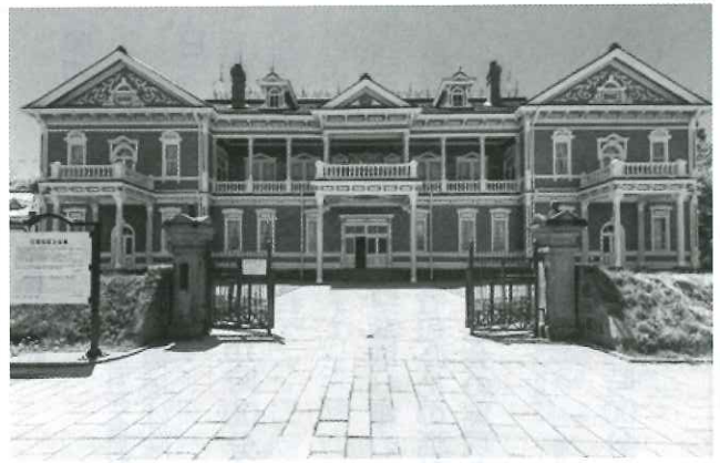
重要文化財 旧函館区公会堂
